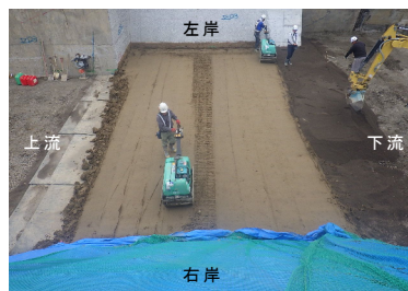
Pic.4 転圧状況(ダム軸) Compacting soils
