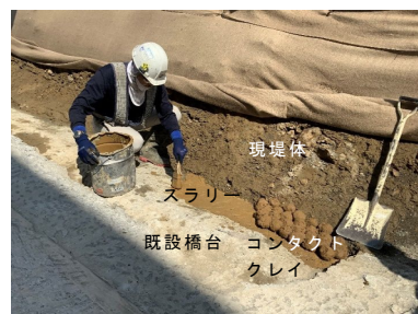
Pic.2 最下部の盛立 Embankment at bottom
